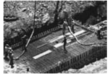
FIGURA 12-22 Varillas de acero alrededor de las cuales se vierte concreto para lograr resistencia.
