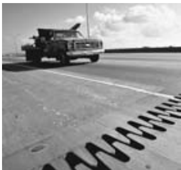
FIGURA 17-3 Juntas de expansión en un puente.
