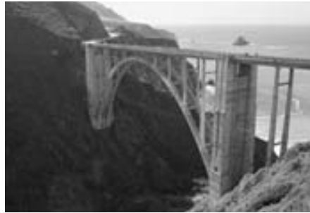
FIGURA 12-33 Un arco se usó aquí para salvar una barranca en la costa de California.
