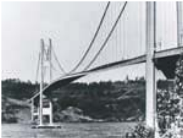
FIGURA 14-25 a) Oscilación de gran amplitud del puente Tacoma Narrows, debido a ráfagas de viento, que condujeron a su colapso (1940). b) Derrumbe de una autopista en California, causado por el sismo de 1989.
