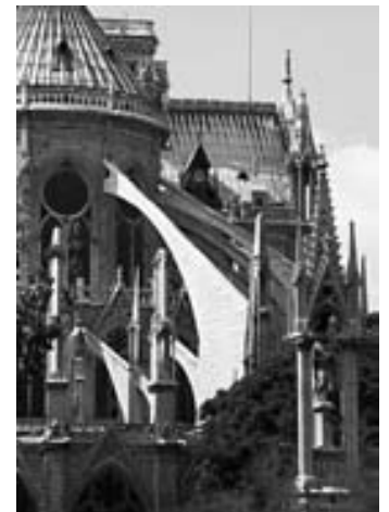
FIGURA 12-35 Contrafuertes volantes (catedral de Norte Dame, en París).
