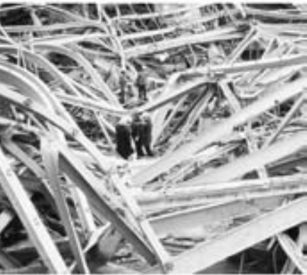
FIGURA 1-1 a) Este acueducto romano fue construido hace 2000 años y aún se mantiene en pie. b) En 1978 el Centro Cívico de Hartford colapsó, sólo dos años después de haberse construido.
