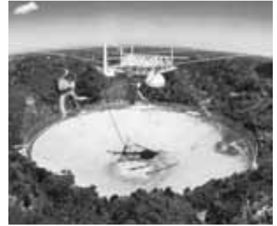
FIGURA 35-16 El radiotelescopio de 300 m de Arecibo, Puerto Rico, usa ondas de radio (figura 31-12) en vez de luz visible.
