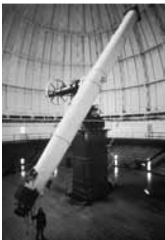
FIGURA 33-37 Este gran telescopio refractor se construyó en 1897 y se alberga en el Observatorio Yerkes, en Wisconsin. La lente del objetivo mide 102 cm (40 pulgadas) de diámetro y el tubo del telescopio mide aproximadamente 19 m de largo. Ejemplo 33-15.
