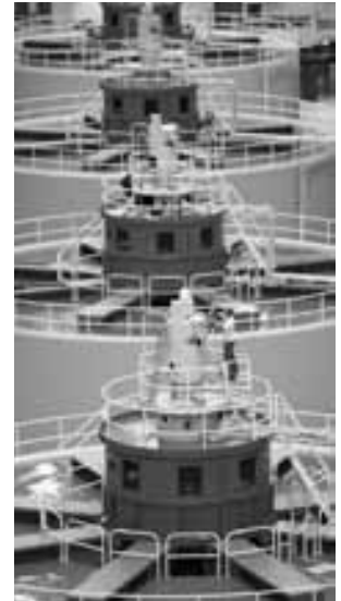
FIGURA 29-17 Generadores impulsados por agua en la base de la presa Bonneville, en Oregon.
