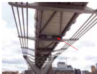
Figura 15.20 El Puente del Milenio de Londres sobre el río Támesis en Londres. El día de la inauguración del puente, los peatones notaron un movimiento oscilante del puente, lo que le valió el nombre de "Puente tambaleante". El puente se cerró después de dos días y permaneció cerrado durante dos años. Se agregaron al puente más de 50 amortiguadores de masa sintonizados: los pares de estructuras accionadas por resorte en la parte superior de los miembros transversales (flecha).
