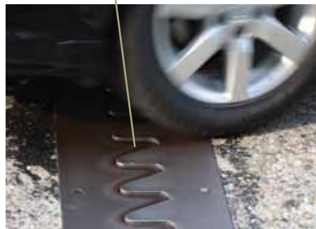
Figura 18.7 Juntas de expansión térmica en (a) puentes y (b) paredes.
