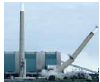
Figura 10.13 (Ejemplo conceptual 10.5) Una chimenea que cae se rompe en algún punto a lo largo de su longitud.
